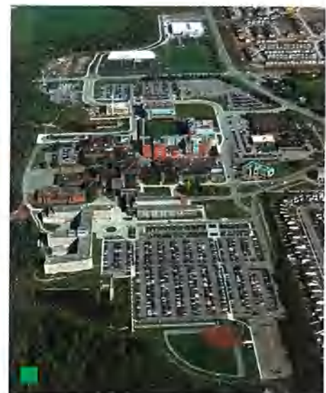
Aerial view from the south, three years into construction/Vue aérienne depuis le sud, trois ans après le début des travaux
